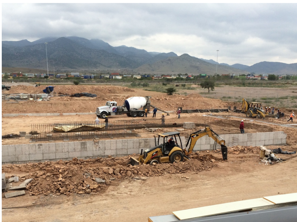
Il nuovo impianto di compounding Technyl® di Solvay in costruzione a San Luis Potosí, Messico. (Foto di Solvay)
