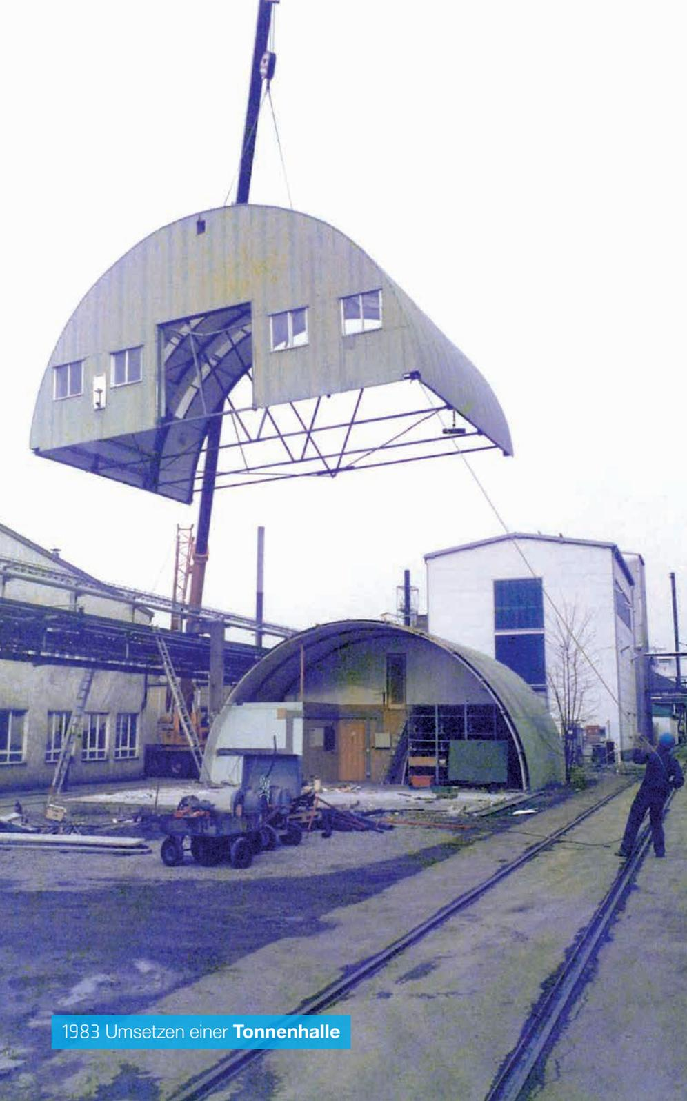
1983 Umsetzen einer **Tonnenhalle**
