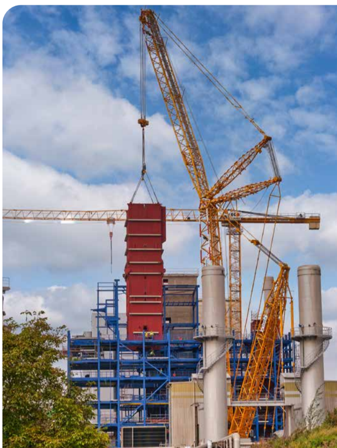
Anfang Oktober hob ein 1.000-Tonnen-Kran in rund 40 Meter Höhe einen Kessel in den Brennraum des neuen Kraftwerks – ein weiterer Meilenstein des Nachhaltigkeitsprojekts wurde damit erreicht.
