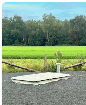
Ersatzbrunnen in Doernern. Aus rund 140 Meter Tiefe fördert die SGW seit Anfang des Jahres Grundwasser für die Solegewinnung.
