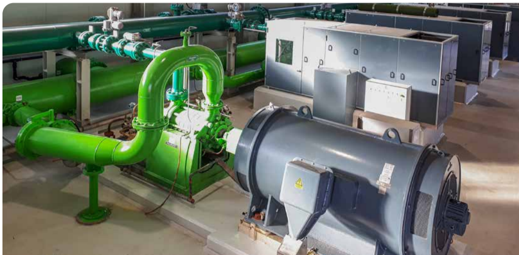
Moderne und energieeffiziente Pumpen senken den Stromverbrauch der SGW deutlich, seit 2014 um mehr als 25 Prozent.
