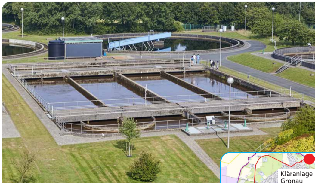
Das Klärwerk Gronau bereitet kommunales Abwasser auf, bevor es in die Dinkel abgeleitet wird. Ein Teil dieser gereinigten Wassermenge soll künftig über eine Leitung zur SGW gelangen.
