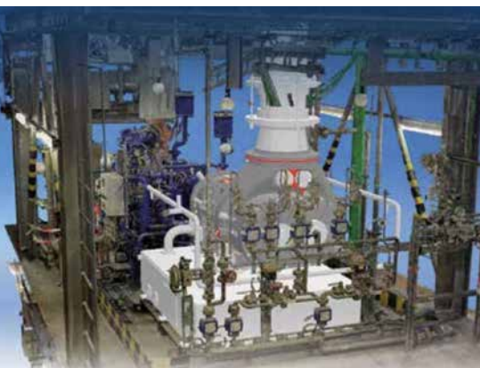
Ansicht der Verdichteranlage in der Sodaproduktion als 3D-Punktwolke via Laserscan (links). Die geplante Anlagenkonstruktion wurde mittels CAD-Software originalgetreu visualisiert.
